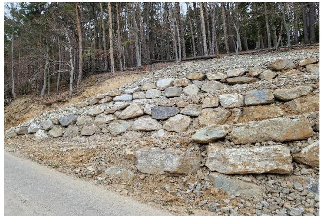
Nach einer Hangrutschung fanden am Gregerbauerweg Sicherungsarbeiten sowie die Errichtung einer Steinschichtung statt. Die finanziellen Mittel für diese Maßnahmen stammen aus dem Katastrophenfonds des Landes.
