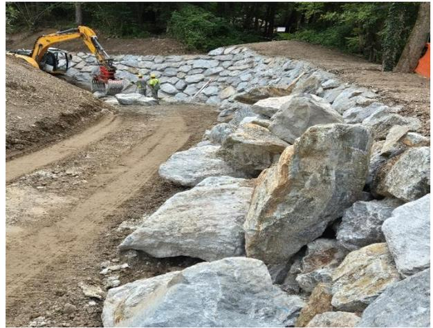
Steinschichtung im Annengraben zur Sicherung der L329
